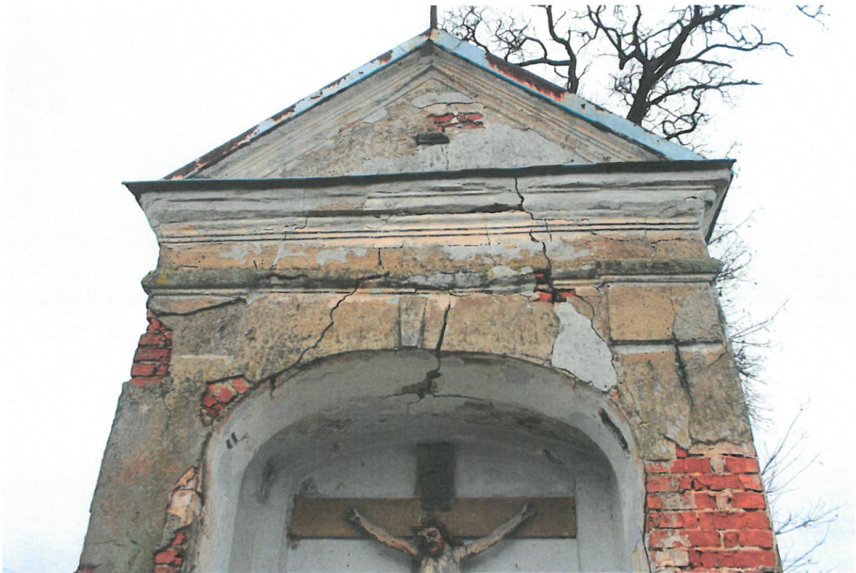
ZDJ. 5 BAJKI ZALESIE. KAPLICZKA DWORSKA. GÓRNY FRAGMENT WNĘKI – WYRAŻNE OBSUNIĘCIE SIĘ PĘKNIĘTYCH I ROZSPOJONYCH FRAGMENTÓW ŁUKU SPOWODOWANE SZEROKĄ ROZPIĘTOŚCIĄ ŁUKU KOSZOWEGO I USUNIĘCIEM BŁKI STĘŻAJĄCEJ Z PODŁUCZA
