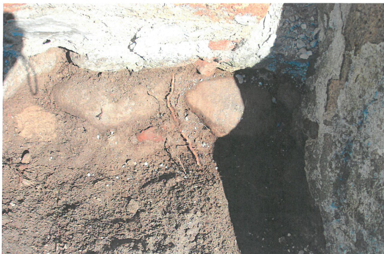
ZDJ.8 BAJKI ZALESIE. KAPLICZKA DWORSKA. FUNDAMENT Z KAMIENI POLNYCH
