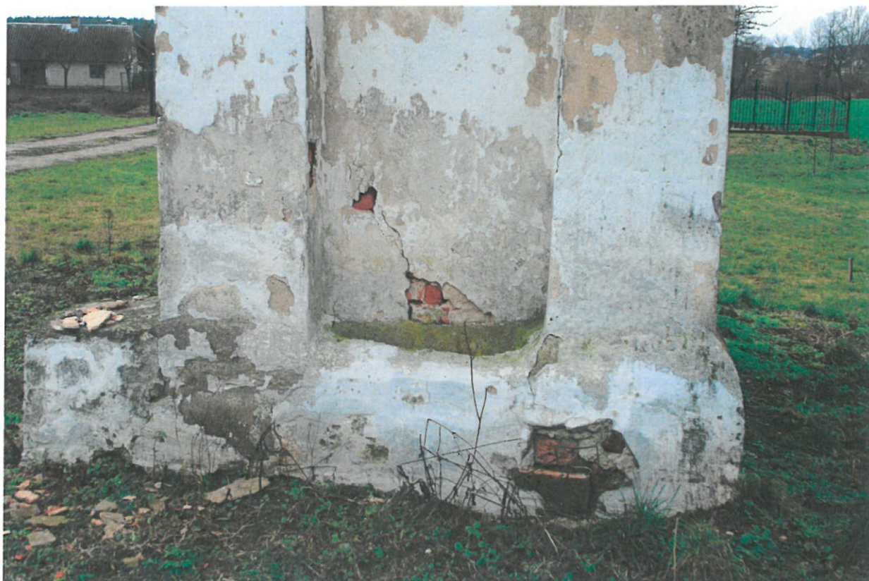
ZDJ.7 BAJKI ZALESIE. KAPLICZKA DWORSKA. PRAWY BOK KAPLICZKI. WIDOCZNE PĘKNIĘCIE I ROZLUŻNIENIE COKOŁU I ŚCIANY WSKAZUJĄCE NA DZIAŁANIE SIŁ ROZPOROWYCH W OBREBIE ŁUKU WNĘKI
